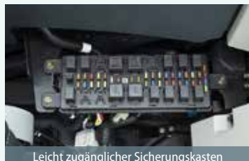
Leicht zugänglicher Sicherungskasten
