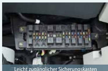
Leicht zugänglicher Sicherungskasten
