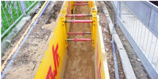
Arbeitsbreite **Leichtverbau**: 0,66 – 2,23 m
